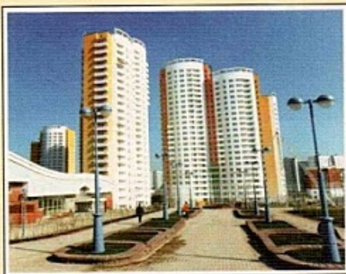
Фото Юрия Быковского
