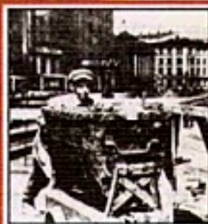
Москва строится, 30-е годы XX века.
